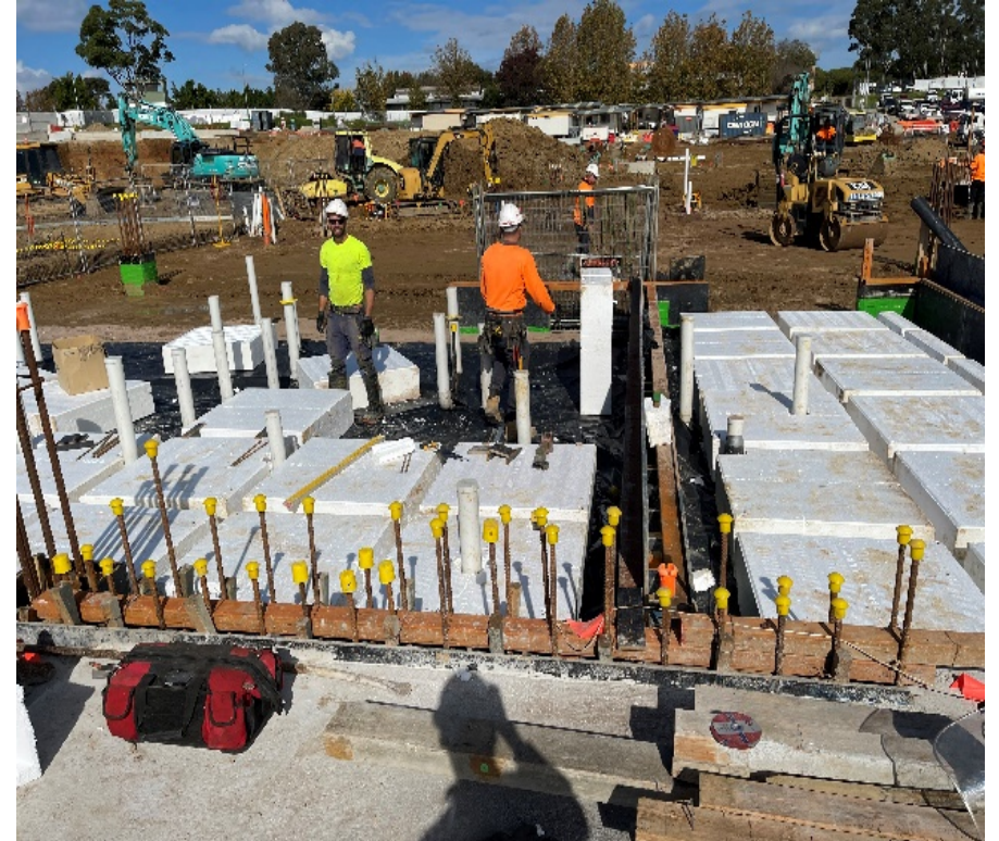
Preparation for Central Atrium concrete pour
